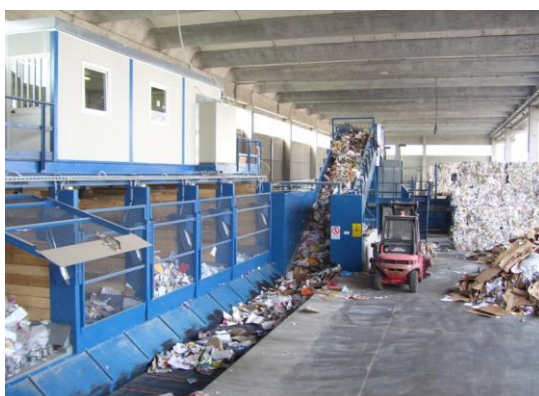
Vista impianto di selezione meccanica della carta
